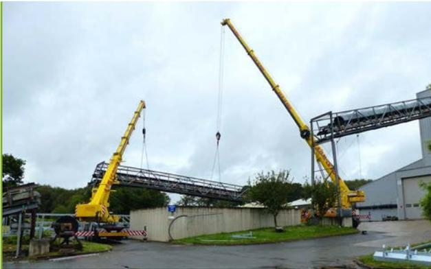
Suite à un accrochage du convoyeur d'alimentation de la tour d'affinage par un camion-benne d'un prestataire extérieur, la section endommagée a été remplacée par un nouveau convoyeur. La délicate opération a été réalisée par l'entreprise Castel de Landivisiau.
